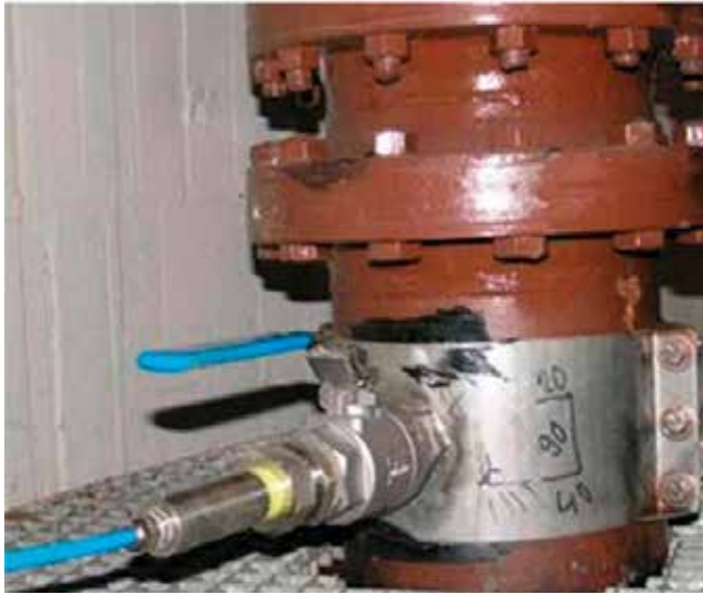
Anborningsbygel på gjutjärnsrör
