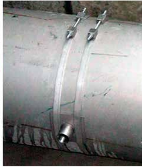
Spännband och stålplatta med påsvetsad stös.
